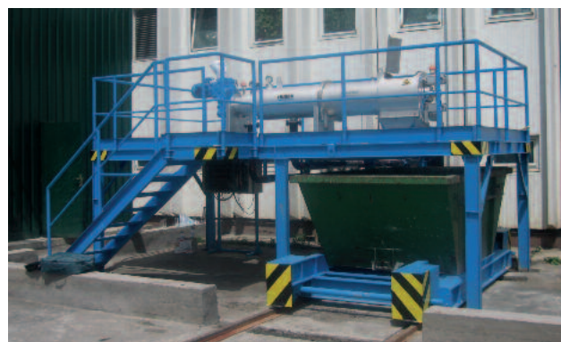
Установка пресса для фильтрации осадка от механических загрязнений HUBER STRAINPRESS® вне помещения
