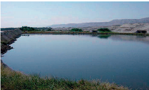
In wasserarmen Gebieten Israels wird Abwasser nach Feinstsiegung und Behandlung in Abwasserteichen im Wasserreservoir gespeichert und zur Bewässerung genutzt
