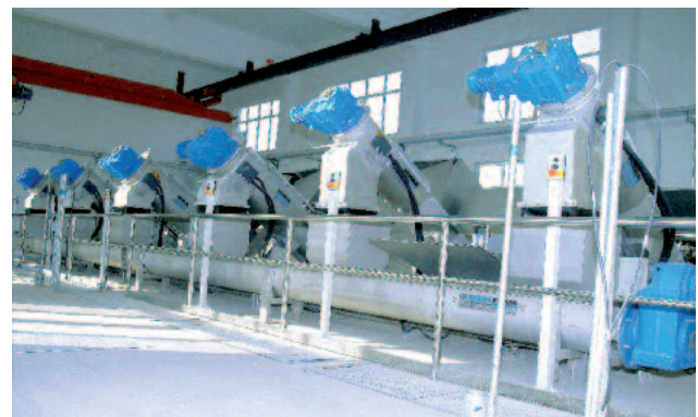
Reihe von ROTAMAT® RoMem Feinstsieben mit Trogschneckenförderern Ro 8t für das Siebgut
