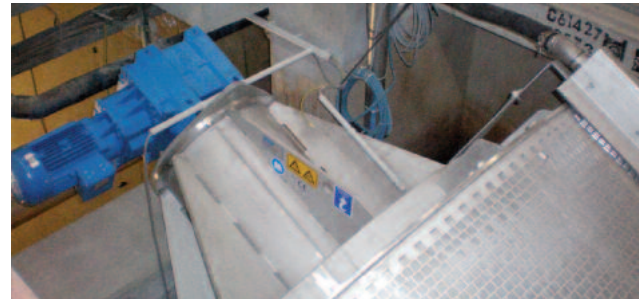
Einsatz für River or Sea Outfall: Feinstsiegung mit der RoMem liquid
