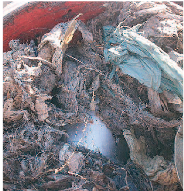
Tausende Tonnen von Rechengut können bei Anwendungen für River oder Sea Outfalls über eine Siebstufe vom Gewässer ferngehalten und umwelt-schonend entsorgt werden.
