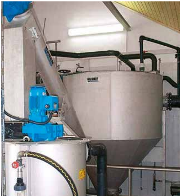
HUBER Rundsandfang HRSF mit integrierter Klassierschnecke und nachgeschalteter HUBER Sandwaschanlage RoSF4 T.
