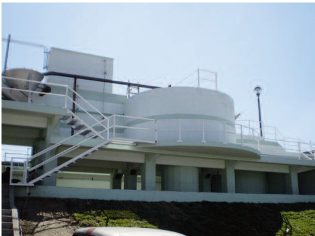
Desarenador tipo Vortex HUBER VORMAX instalado con un clasificador de arenas HUBER RoSF 3 posterior.
