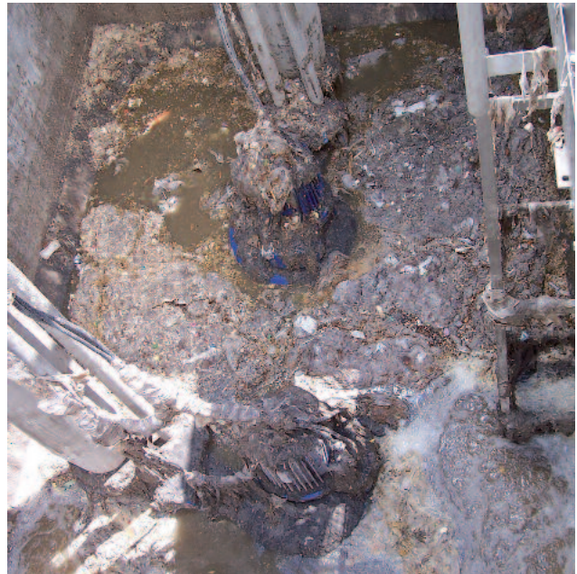
Pompes obstruées par des solides
