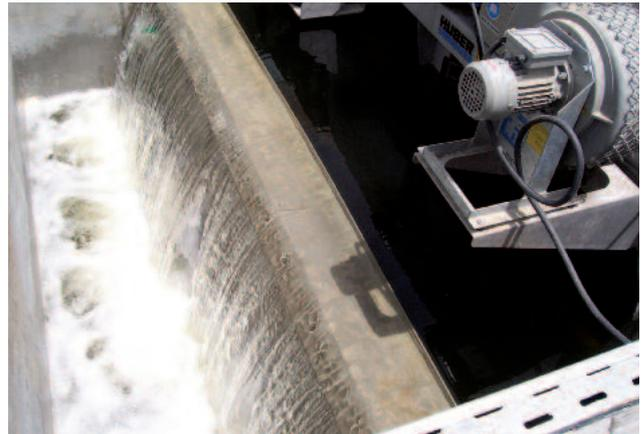
*Efluente limpio y casi completamente libre de sólidos de un filtro de disco RoDisc®*
