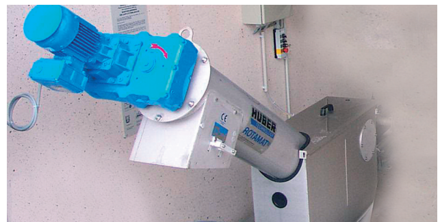
Решетка HUBER ROTAMAT® Ro9 EC, установленная в резервуаре
