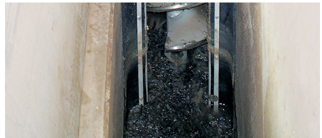
Решетка HUBER ROTAMAT® Ro9 XL с керамическим подшипником, неприхотливый в обслуживании
