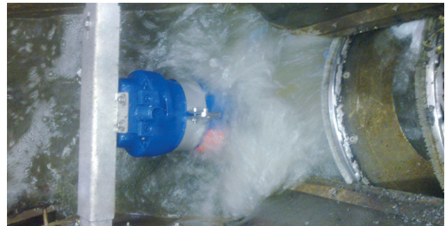
Внешняя система промывки отбросов (ERGA) смывает органические вещества.
