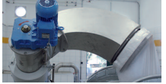
Doğrudan konteynere deşarj için sonradan eklenmiş yan tutulan malzeme deşarj şutu
