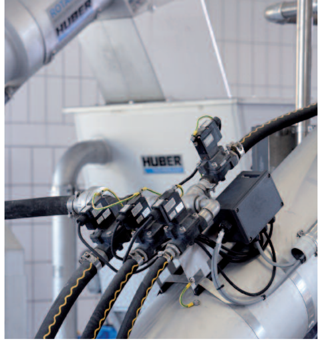
ROTAMAT® Döner Tamburlu İnce Izgara entegre tutulan malzeme yıkama sistemi IRGA ile birlikte
