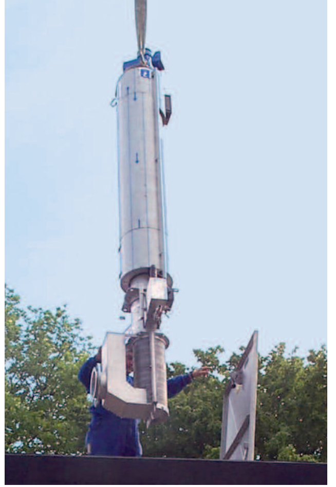
ROTAMAT® Pompa İstasyonu Izgarası RoK 4 pompa istasyonuna yerleştiriliyor.
