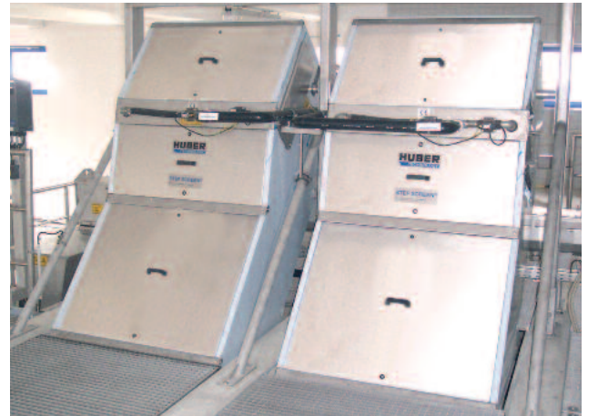
Paralel kanallar içine kurulmuş 2adet STEP SCREEN® Esnek SSF üniteleri
